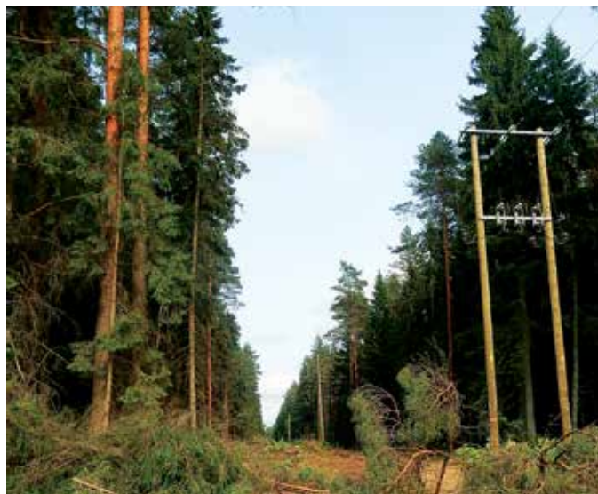
Elektrolīniju trase ir elektroliniju darbības nodrošināšanai paredzēta dabā esoša josla, kas uzturama brīva no kokiem un krūmiem
